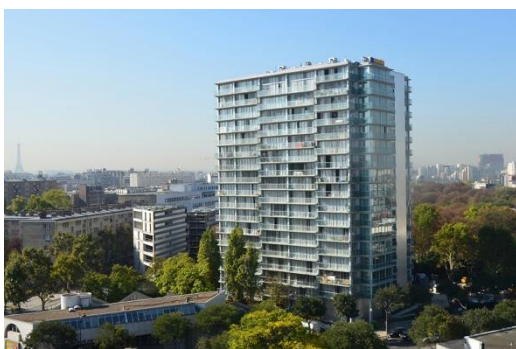
Figura 8: Torre Bois Le Prêtre, París, Francia. Lacaton y Vassal, 2011 Fuente: Wikicommons
