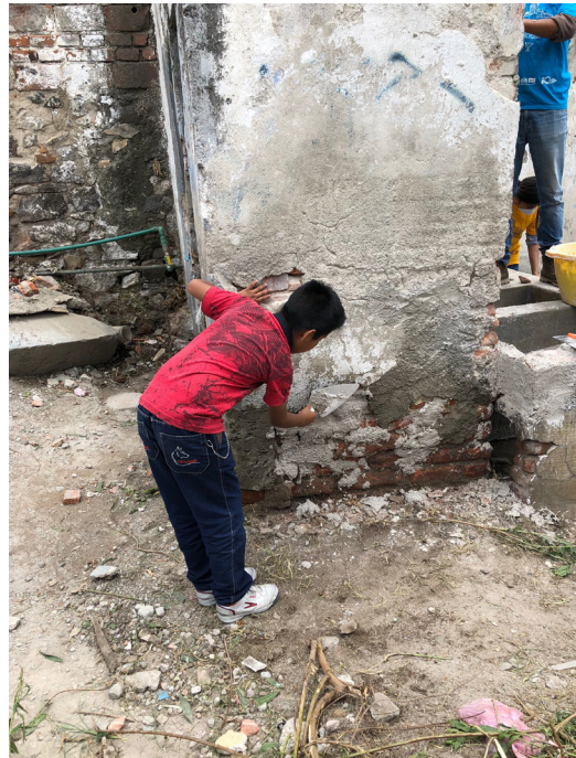
Figura 10: Niño realizando labores de albañilería en muro de baños colectivos Fuente: propia (2018)
