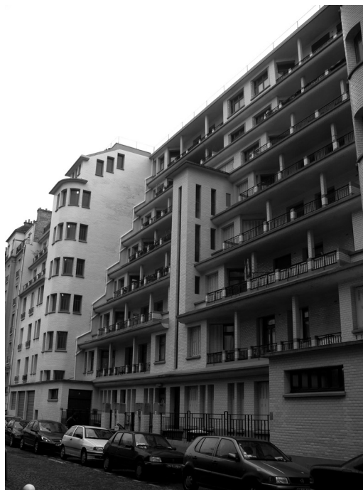
Figura 6: Fachada meridional del inmueble à gradins de Henri Sauvage en la Rue des Amiraux de París, 1923-1925 Fuente: R. Mathis, (2011). Wikimedia Commons. (CC BY-SA 3.0)
