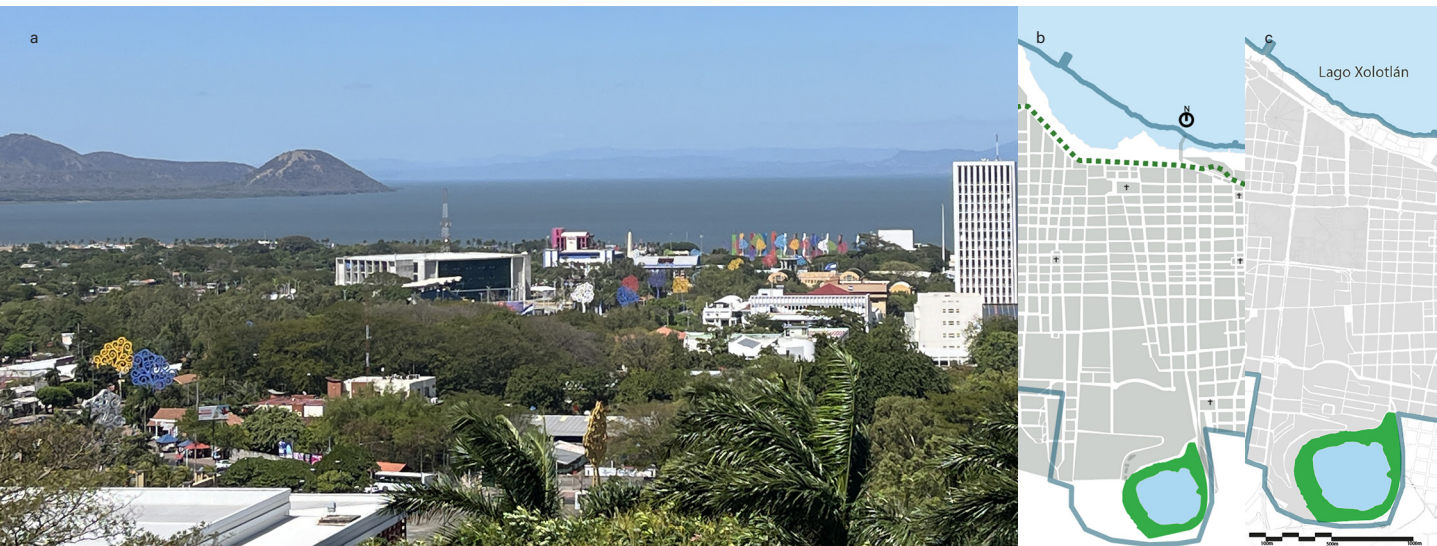
Figura 9: Franja central del CH de Managua: a) Vista sur-norte, 2024, b) trama 1972, c) trama actual. (2024)
