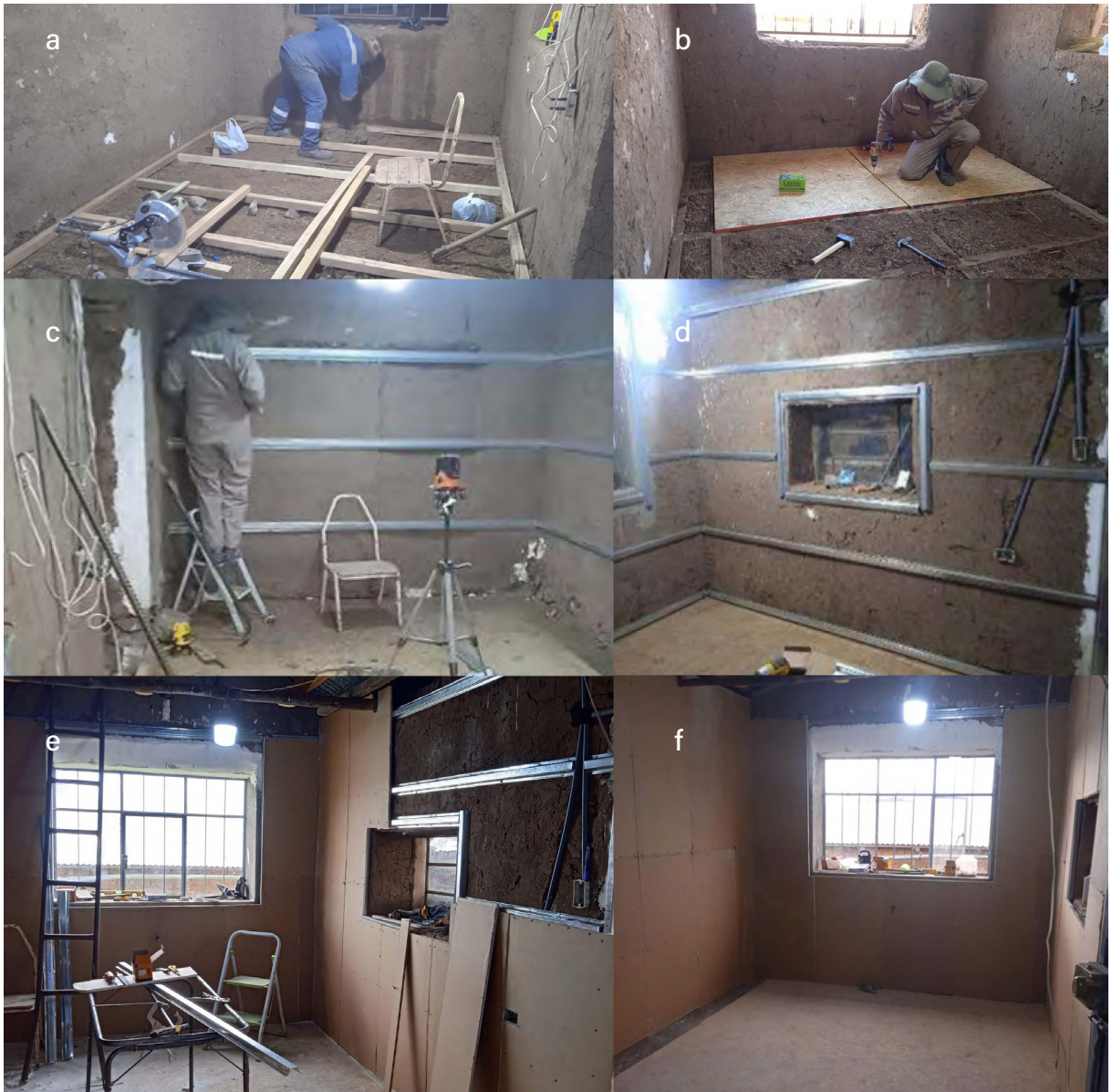
Figura 7: (a) Estructura de madera en piso. (b) Colocación de planchas OSB. (c) Colocación de perfiles galvanizados. (d) Colocación de instalaciones eléctricas. (e) Colocación de paneles. (f) Acabado del ambiente interior. (2024)
