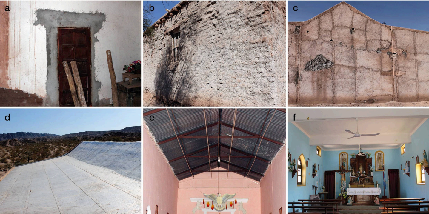
Figura 5: a) Erosión por lavado diferencial en la fachada de San Pedro. b) Interior del campanario de la iglesia de Andacollo. c) Exterior de la iglesia de Anillaco. d) y e) Faltantes parciales por desprendimientos del cielorraso de revoque en las capillas de Santa Lucía y Andacollo. f) Erosión por viento - Capilla de Andacollo. (2024)
