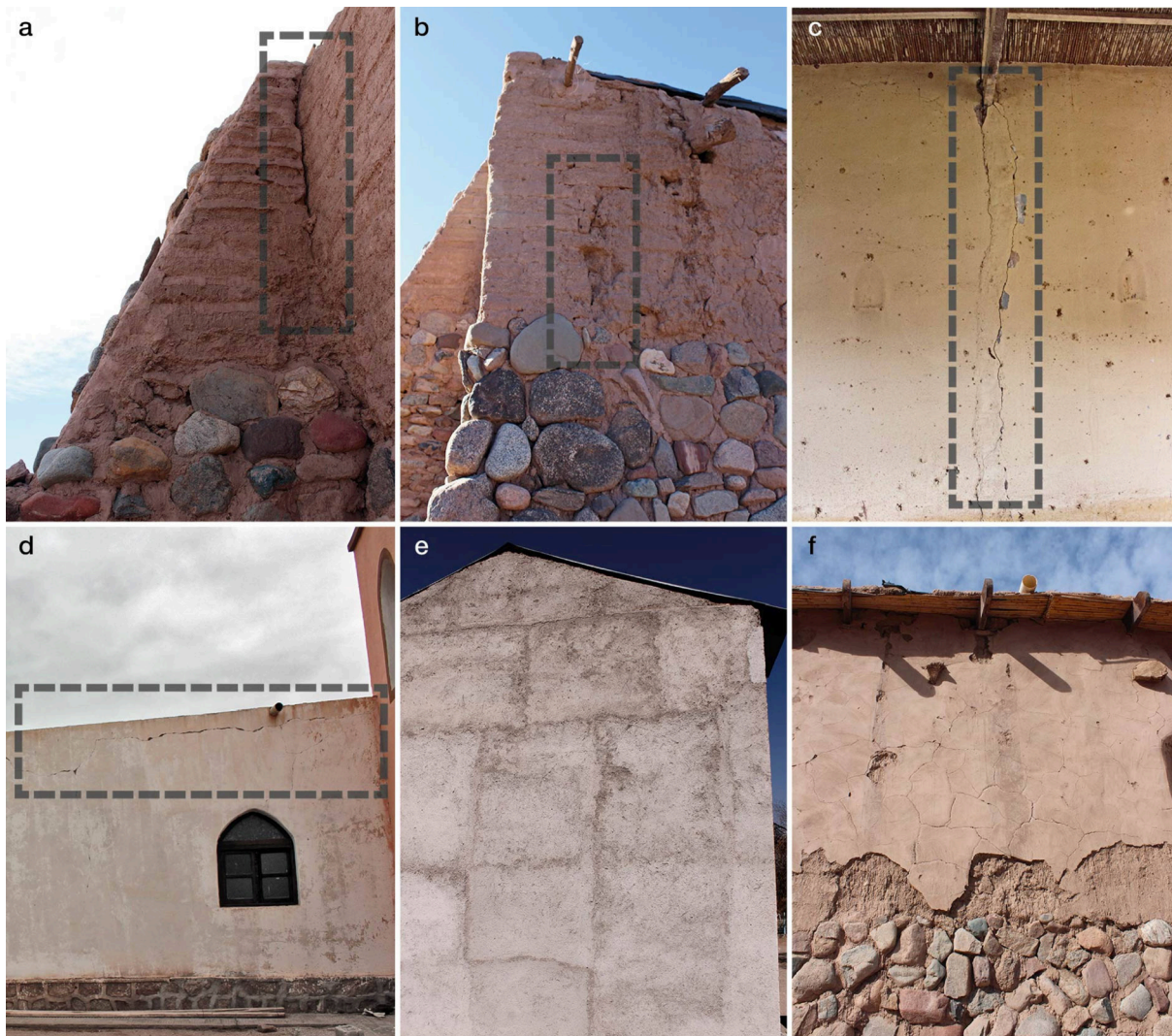
Figura 6: a) y b) Grietas por ausencia de traba entre estructuras existentes y agregadas - Capilla de Anillaco. c) y d) Grieta por sobrecarga puntual - Capilla Santo Domingo y por empuje horizontal - Capilla Virgen de la Medalla Milagrosa. e) Fisuras producidas por tensiones entre los paños de reposición - Capilla Santa Lucía. f) Craquelado por retracción del revoque - Capilla de Anillaco. (2024)
