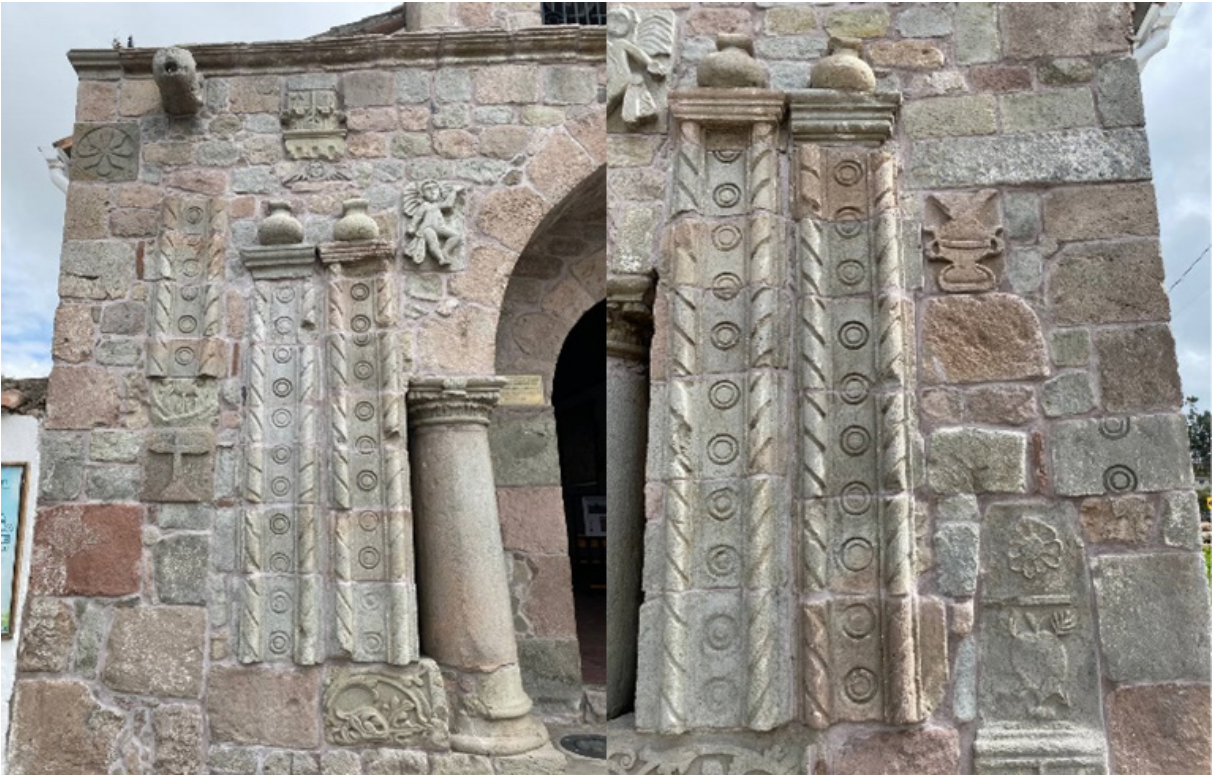
Figura 4: Detalle de arco fachada frontal de la Iglesia de San Lorenzo de Sicalpa. (2024)
