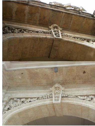
Figura 7: Limpieza de la piedra antes y después Fuente: A. Cortiñas, 2012 – 2015
