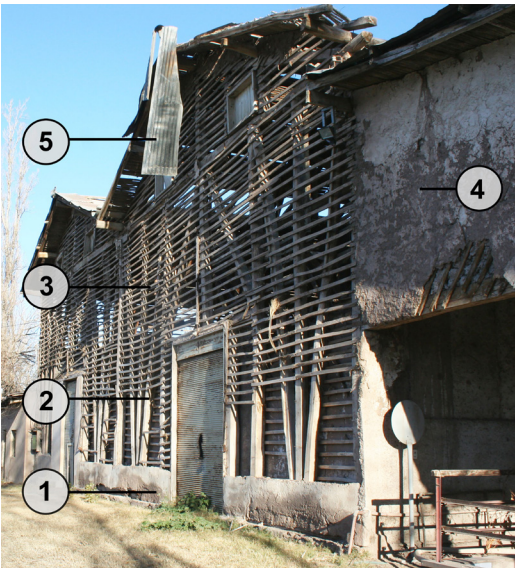
Figura 4: Vivienda y bodega donde se observa el sistema de la quincha en Guaymallén y sus componentes. Fuente: Propia.
