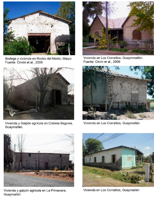
Figura 5: Fotografías donde se muestra el patrón constructivo del sistema de la quincha en la zona del Cinturón Verde de Mendoza. Fuente: Propia y Cirvini et al., 2009
