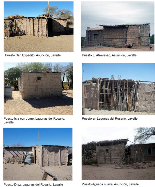
Figura 3: Diferentes viviendas donde se observa la resolución constructiva de la quincha en tierras secas no irrigadas.
