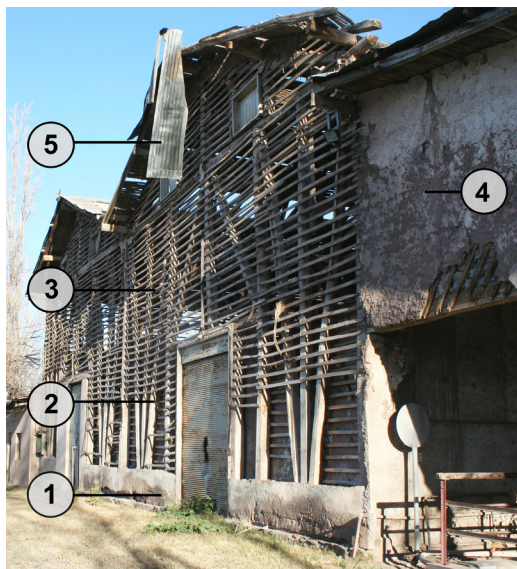
Figura 4: Vivienda y bodega donde se observa el sistema de la quincha en Guaymallén y sus componentes.
