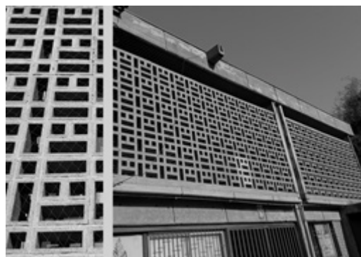
Figura 7: Detalles de la envolvente en hormigón prefabricado y actual vista en la fachada del casino del Campus
