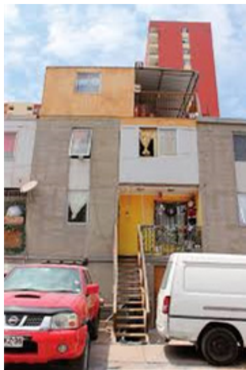
Figura 11: Vivienda que crece hacia el 4to. Nivel en Quinta Monroy, Iquique- Chile Fuente: Fotografía tomada de Millones (2017)
