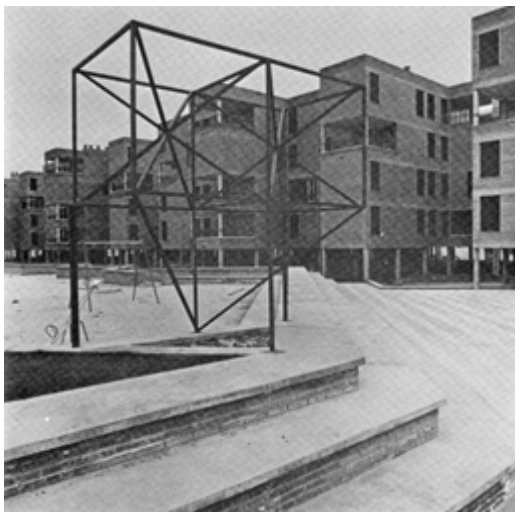
Figura 15: Viviendas en Torrejón de Ardoz, 1973-1977. Espacios intermedios en 1978 Fuente: Bravo, 1978, p. 87.
