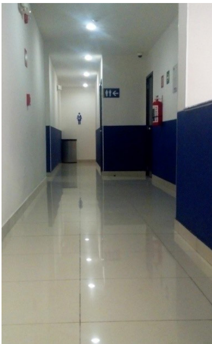
Figura 5: Los sanitarios son solucionados en condiciones confusas y sin posibilidad de asociación
