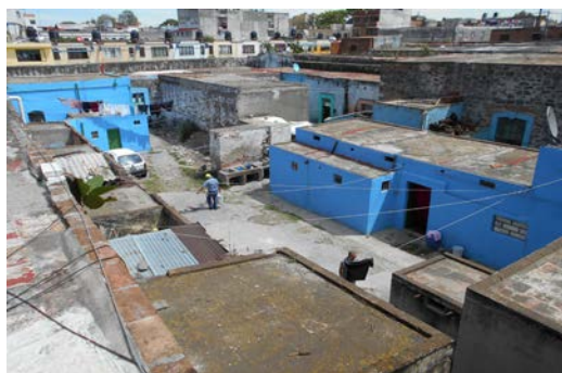
Figura 3: Vista general del patio principal de la vecindad del Pocito, con el módulo de sanitarios y lavaderos colectivos
