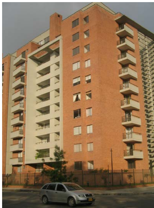
Figura 3: Ejemplo de cerramientos de los conjuntos cerrados en Bogotá
