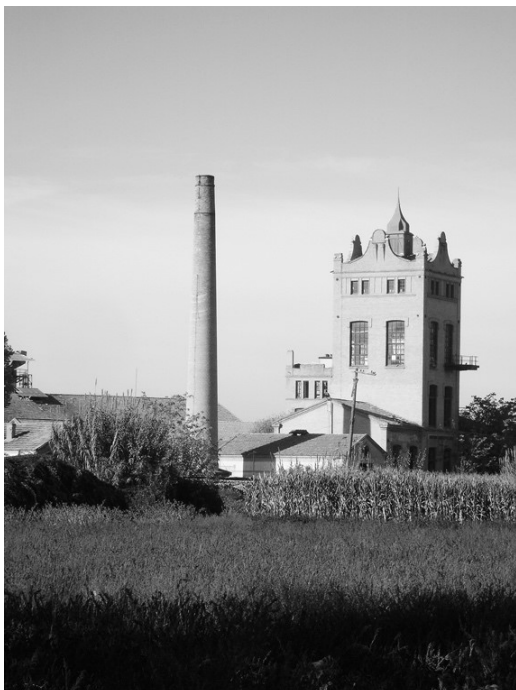
Figura 2: Torre de la Alcoholera y chimenea de la Azucarera de San Isidro (Granada) Fuente: Fotografía del Autor (2015)
