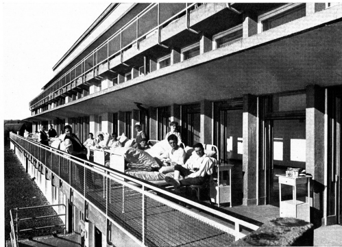
Krankenhaus Waiblingen: Erdgeschossterrasse an einem Sonntag im November 1928. Einblick rechts in das dahinter liegende leere Krankenzimmer, Besonnung desselben durch die über dem Schüttdach angeordneten Oberlichtfenster. Bei dem niedrigen Sonnenstand vollständige Besonnung der Terrasse. 14
