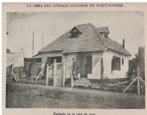
Figura 3: Vista de la Casa de Yeso, prototipo de vivienda higiénica construida en calle San Luis, Independencia
