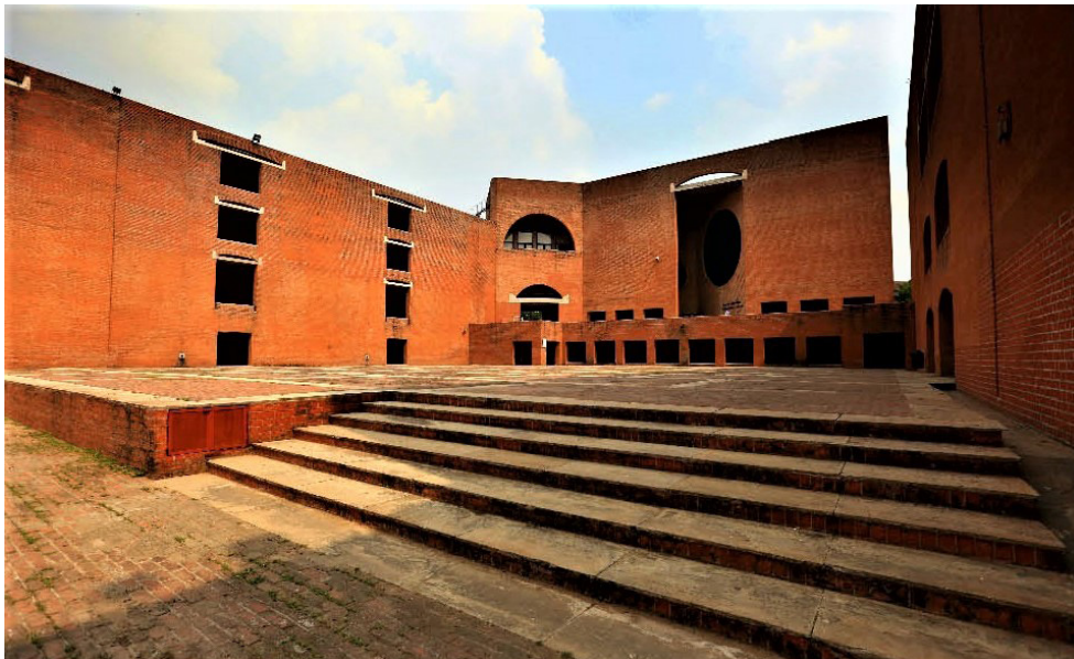
Figura 7: Biblioteca del IIMA antes de la restauración Fuente: © Cortesía de SNK.
