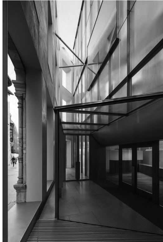
Figura 4: Ampliación del Museo de Bellas Artes de Asturias. Intersticio entre las dos fachadas
