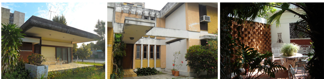
Figura 7. Soluciones de diseño que favorecen el confort ambiental: aleros, persianas de madera y patios interiores con vegetación en Santa Catalina Fuente: Autores (2020)
