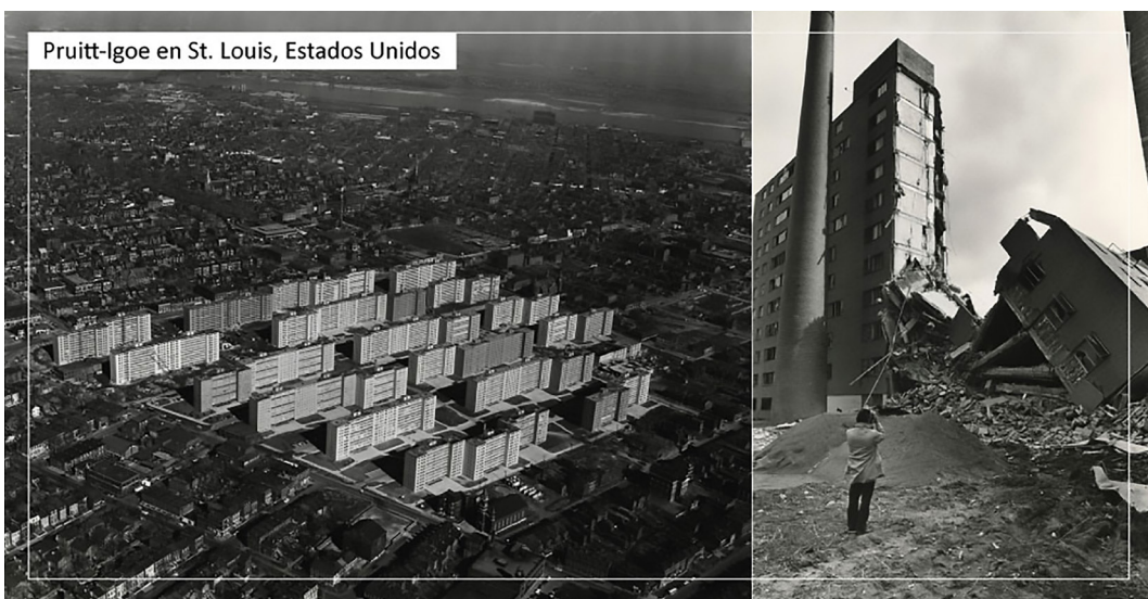
Figura 1: Demolición proyecto Pruitt-Igoe en St. Louis, Estados Unidos Fuente: Autores (2022) basados en imágenes de Película “The Pruitt Igoe Myth” (Freidrichs, 2011)
