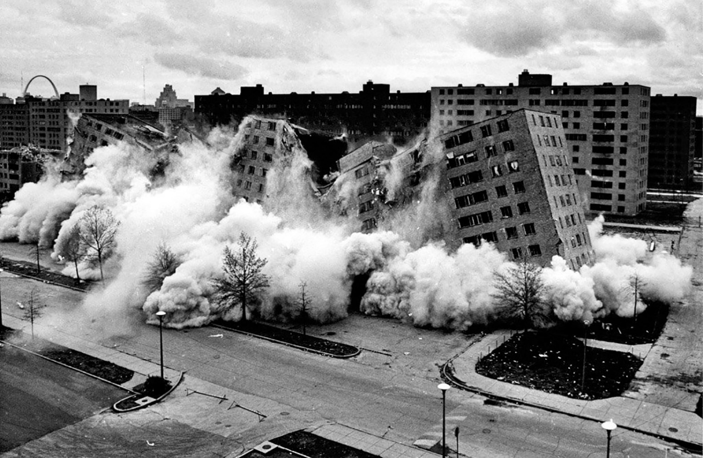
Figura 2: El idealismo semiótico ocurre cuando los objetos no se referencian con los contextos donde se construyen. Demolición de conjunto moderno Pruitt-Igoe , 1972 Román (2019)
