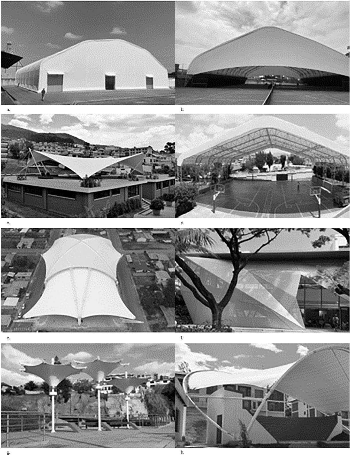
Figura 3: Estructuras de membrana tensada permanente en Ecuador a) Cubierta industrial. b) Cubierta deportiva. c) Cubierta educación. d) Cubierta educativa/deportiva. e) Cubierta de plazas. f) Aplicación en fachada. g) Elementos de sombra. h) Concha acústica. Tenzo (2024)
