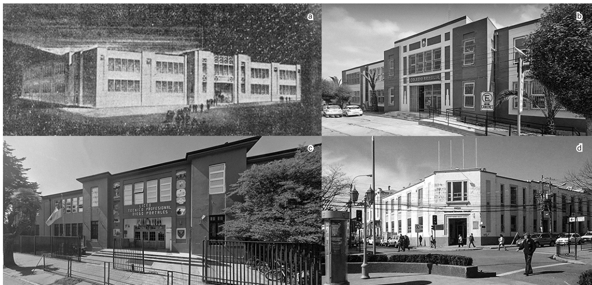
Figura 12: Escuelas estandarizadas norte y sur de Chile. a) Escuela Santa María, Iquique. Dirección de Obras Públicas, Depto. de Arquitectura, 1929. b) Escuela Brasilia, Limache. Autores basados en Google Earth (s.f.). c) Escuela Standard (Liceo Diego Portales), Linares. Los autores basados en Google Earth (s.f.). d) Biblioteca, Los Ángeles. Servicio Nacional de Patrimonio Cultural (2014)
