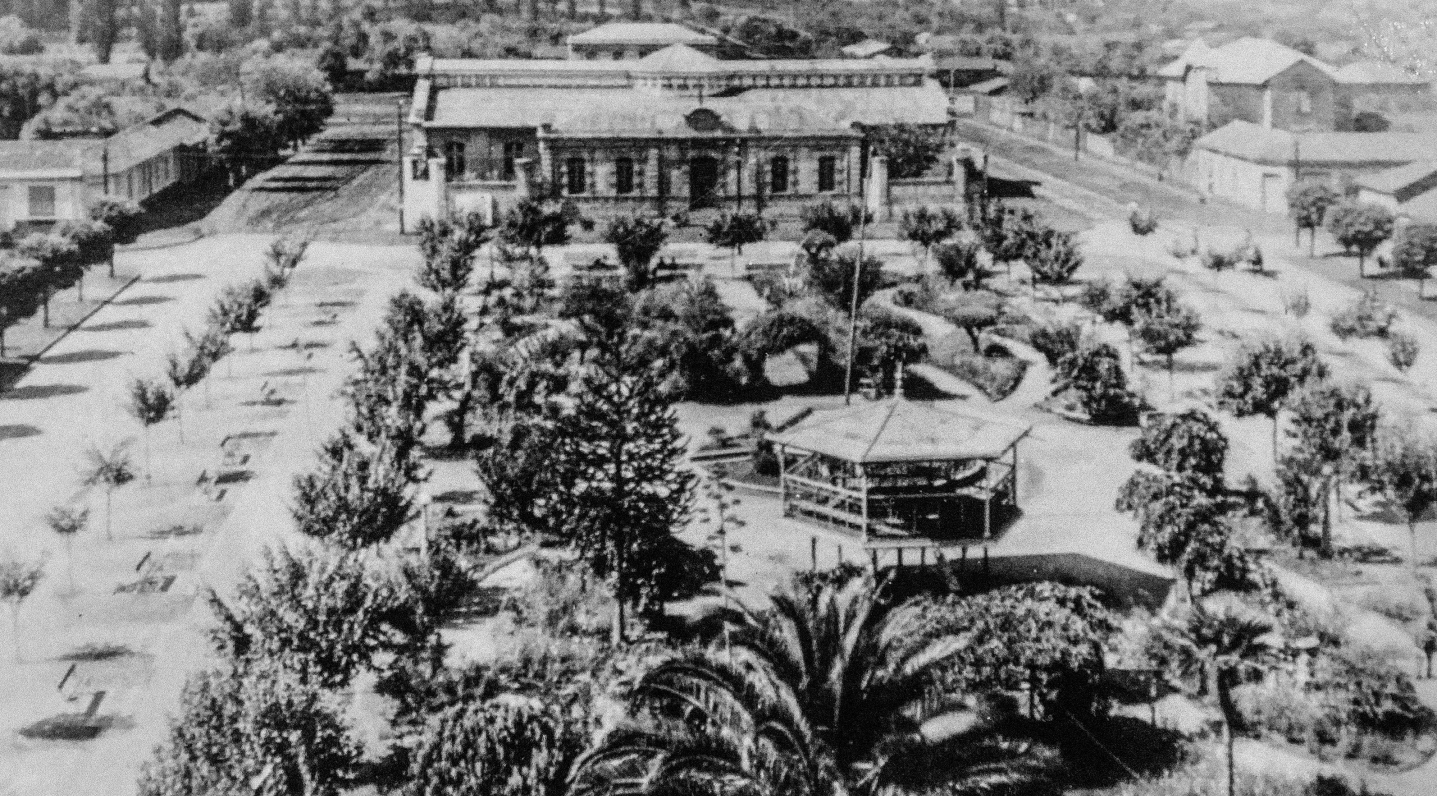
Figura 3: Escuela Superior de Hombres N° 1, vista desde la nueva Plaza de Armas Collipulli. Radio Viaducto, (2023)
