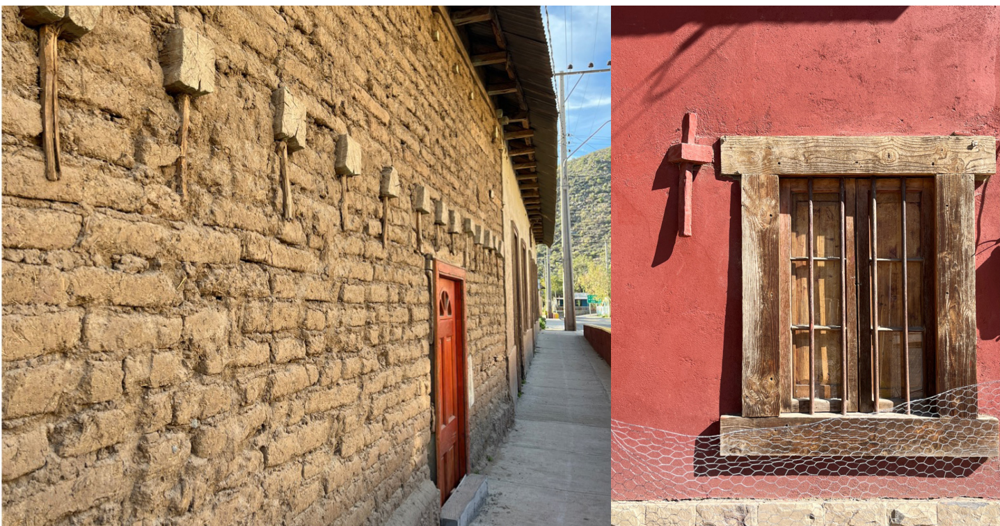
Figura 7: "Candados" de refuerzo sísmico. (2024)
