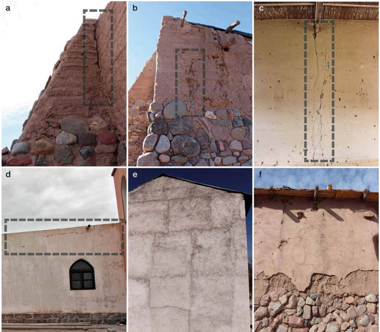
Figura 6: a) y b) Grietas por ausencia de traba entre estructuras existentes y agregadas - Capilla de Anillaco. c) y d) Grieta por sobrecarga puntual - Capilla Santo Domingo y por empuje horizontal - Capilla Virgen de la Medalla Milagrosa. e) Fisuras producidas por tensiones entre los paños de reposición - Capilla Santa Lucía. f) Craquelado por retracción del revoque - Capilla de Anillaco. (2024)
