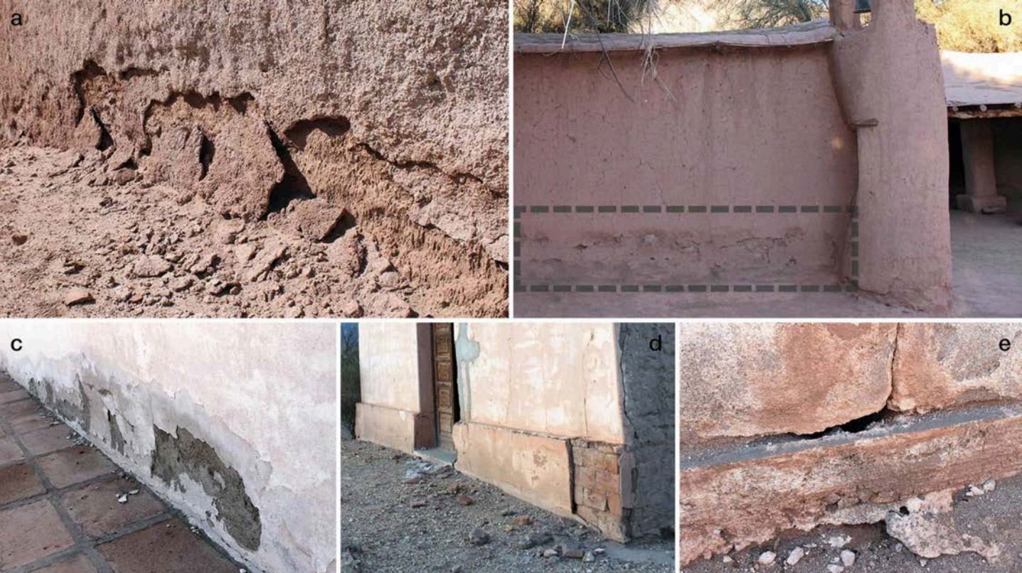
Figura 4: Superior. Desintegración granular y decoloración por humedad capilar en muros. a) Capilla Virgen de las Mercedes y b) Oratorio de los Orquera. Inferior. Soluciones adoptadas para combatir la humedad capilar: revestimiento cementicio. c) Capilla San Pedro d) Zócalo de ladrillo - Capilla Santo de Domingo y de hormigón. e) Capilla Virgen de las Mercedes. (2024)
