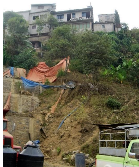
Foto 4. Viviendas ubicadas sobre ladera en proceso de desgajamiento (López, 2011).
