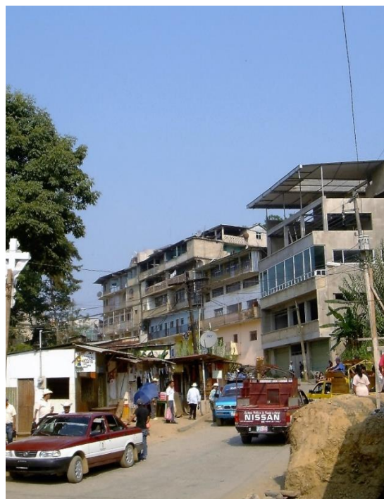
Foto 6. Calle principal del centro de la comunidad, en donde se puede observar la diversidad de materiales y alturas (López, 2011).
