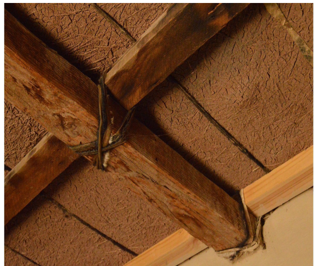
Figura 4: Caruna amarrada con cuero de vacuno. Costaneras y tijerales de madera de pino en bruto
