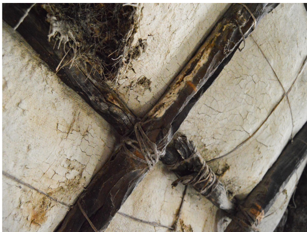
Figura 2: Caruna amarrada con cuero de llamo. Costaneras y tijerales de madera de queñoa.
