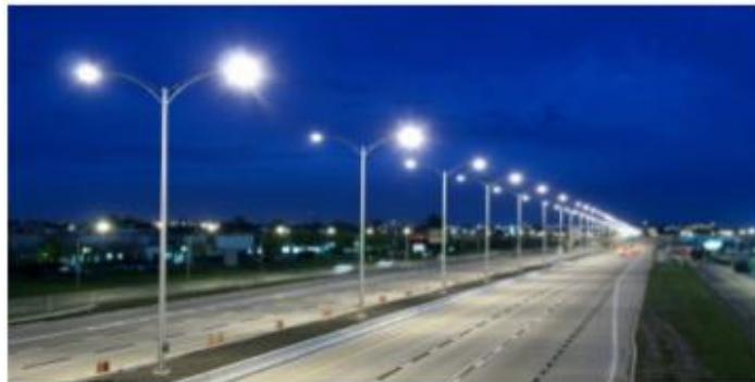
Figura 3. Sistema de iluminación en autopistas (Alzubaidi & Soori, 2012).
