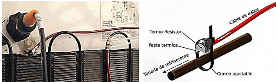
Figura 13. Instalación y montaje de termoresistores externos Fuente: Autores
