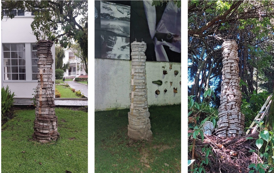
Ilustración 9. Dispositivos actualmente instalados en la ciudad. Dispositivos Biokupas [hormigón compuesto, madera, carrizo, acero estructural]. Elaboración propia.
