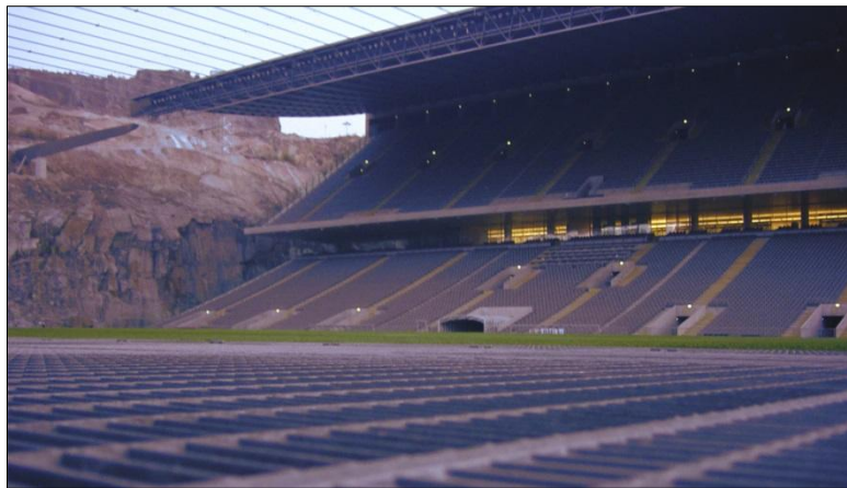
FIGURA 3. Eduardo Souto de Moura. Estadio municipal de Braga (vista del interior) . 2000-2003. Braga (Portugal). (Fotografía: Filipe Garcia)
